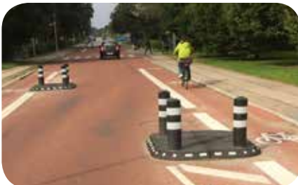
Helleanlæg som indsnævring sænker farten
